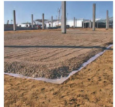
Fig. 1 - Pose de géomembrane
